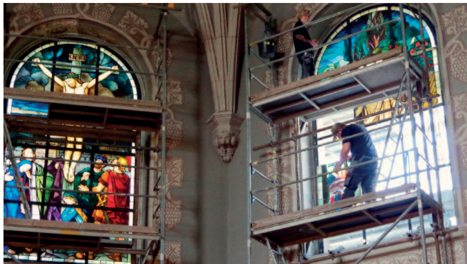
4. Mai: Montage des Auferstehungsfensters
