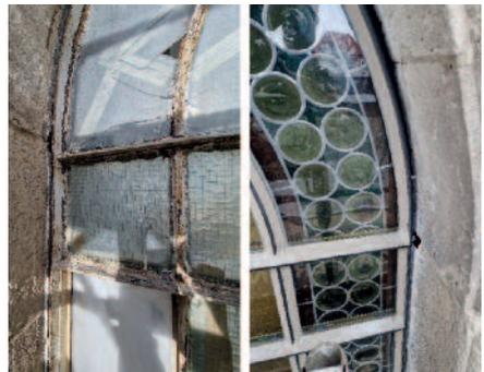
*Details der äußeren Schutzverglasung an einem Fenster der Seitenempore vor und nach der Sanierung*
