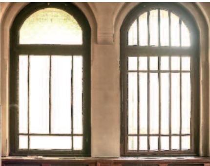
*Fenster im Seitenschiff: links das alte Fenster mit der Kunststoffverglasung und rechts das neue Fenster mit der rekonstruierten historischen Sprossenteilung*
